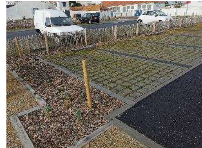
Places de stationnement en pavés à joints enherbés
