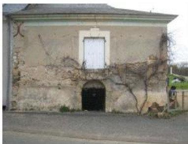
Photo 1 : Entrée grillagée de la cave
